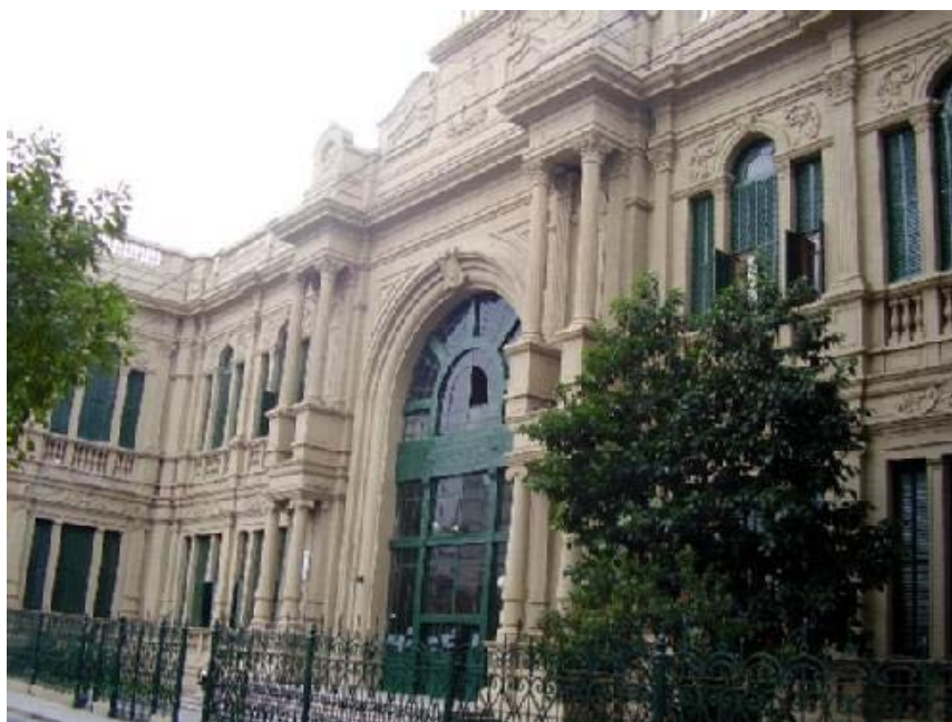
FACHADA actual del Colegio J.L. de Cabrera, sobre calle Santa Rosa
